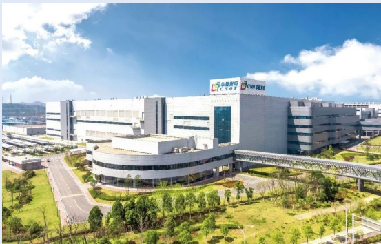
▲支持华星光电 T5 项目建设,助力打造“光芯屏端网”产业集群
