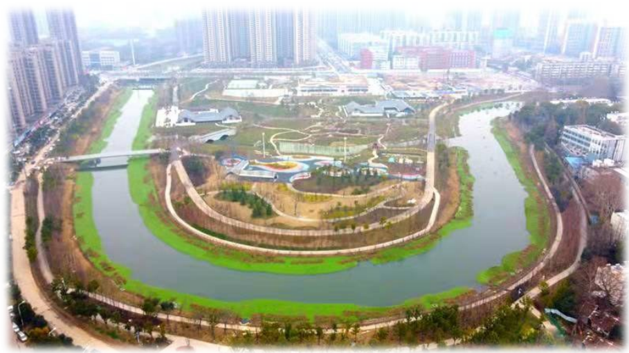
▲巡司河流域经一期、二期综合治理,成为南湖片区靓丽的水生态景观
