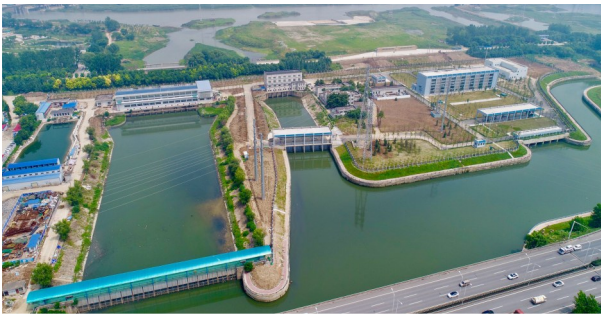
▲ 2021 年 12 月，刚刚建成的后湖四期泵站 获得水利工程行业“国家级优质(大禹)奖”
